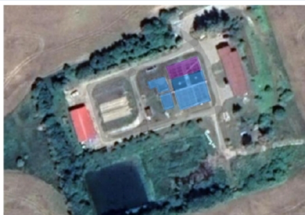
Zakres modernizacji w technologii z próżniowym odgazowaniem osadu
